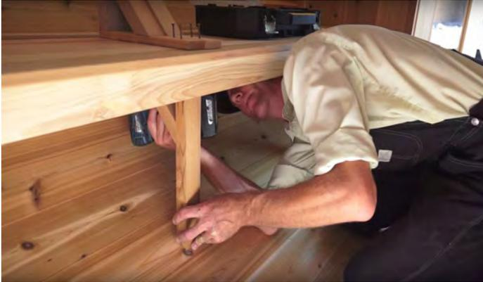
Vissez les supports du banc du bas vers le haut en utilisant 3 vis de 1 ½" (38 mm) dans chaque support.
