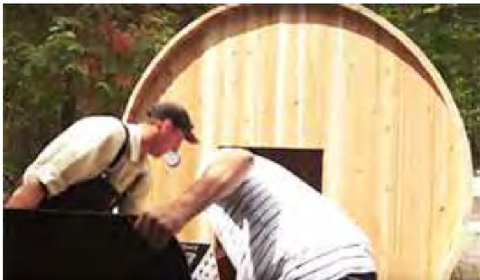
Pour installer le poêle à bois, soulevez le poêle dans le trou situé à l'arrière du sauna.
