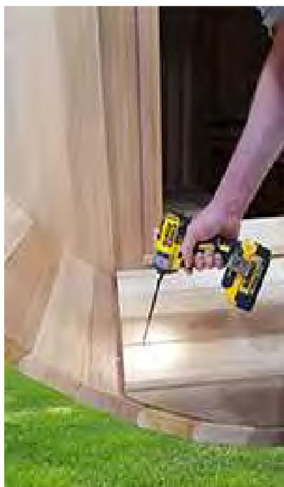
Fixez le plancher du sauna aux douelles du sauna avec des vis de vis de 2 ½" (64 mm).
