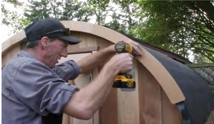
Ajoutez la pièce de garniture suivante au niveau de la première pièce et fixez-la avec une vis de 2" (51 mm).
