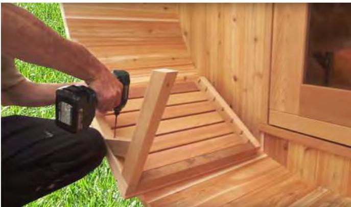
Pour installer les sièges de porche standard, vissez les pieds dans l'extrémité des sièges avec des vis de 2 ½" (64 mm).
