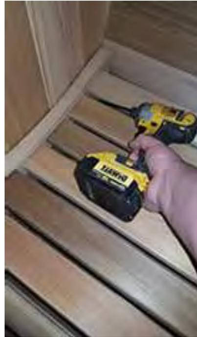
4 vis dans chaque siège, 2 à l'avant et 2 à l'arrière. Vissez entre les planches du siège pour que les vis soient moins visibles.
