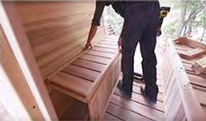
Veillez à ce que le banc soit affleurant et fixez-le avec des vis de 2 ½" (64 mm) entre les planches du siège afin que les vis soient moins visibles.
