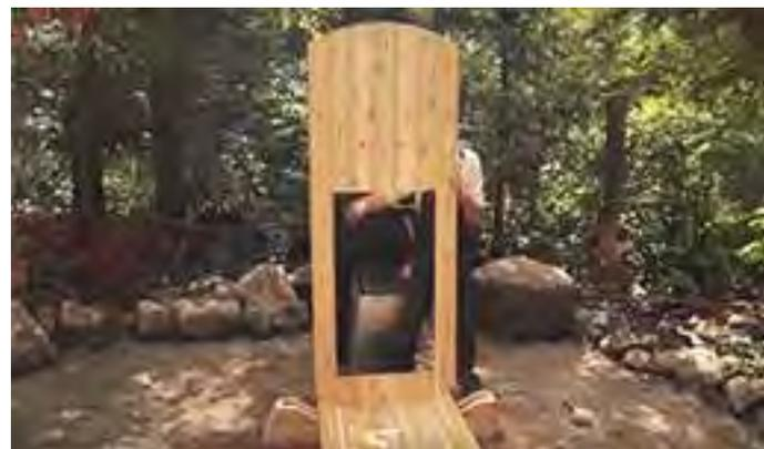
Placez la paroi arrière dans les rainures de la rainure la plus proche de l'arrière du sauna.
