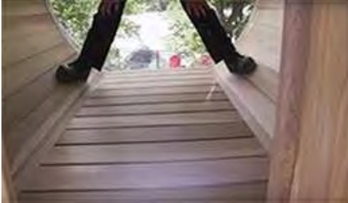
Installez le plancher plat au milieu du sauna en veillant à ce qu'il soit de niveau.
