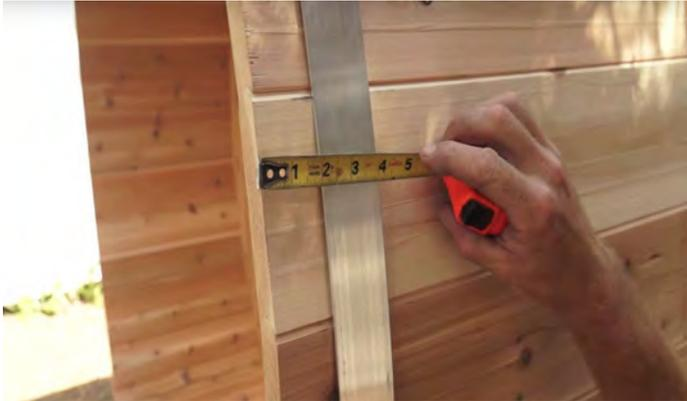
Les bandes avant et arrière doivent se trouver à 2" (5 cm) de l'extrémité des douelles.
