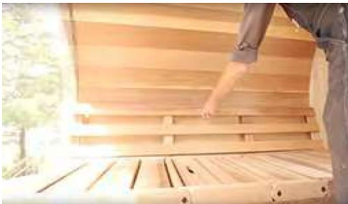
Installez le dossier à l'aide de vis de 2" (51 mm) à la hauteur souhaitée en vous assurant que le banc de salon peut encore fonctionner correctement.
