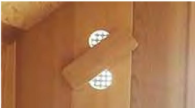
Installez le couvercle d'évent en cèdre sur les trous de sortie à l'intérieur du sauna avec une vis de 1 ½".
