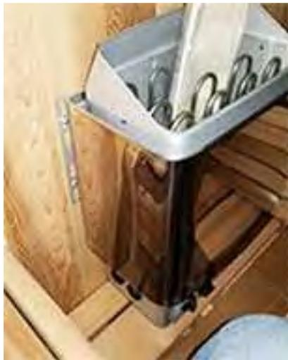
Accrochez l'appareil de chauffage sur les deux vis supérieures.
