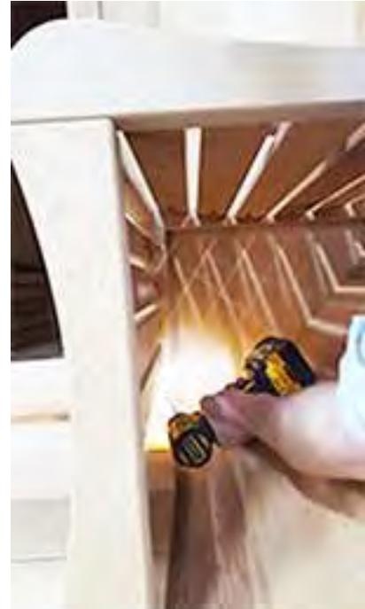
Fixez le banc de porche assemblé au mur avant à l'aide de vis de 2 ½" (64 mm).
