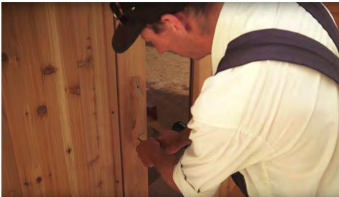
Centrez l'extérieur de la poignée de porte (petite) sur l'extérieur de la porte et fixez-la avec des vis de 2" (51 mm) en utilisant les trous pré-perçés.
