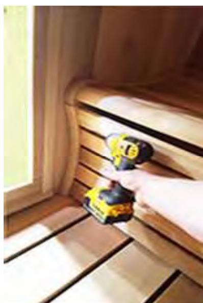
4 vis dans chaque boîtier, 2 à l'avant et 2 à l'arrière. Vissez entre les lattes pour rendre les vis moins visibles.
