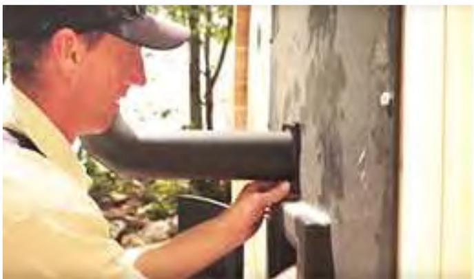
Fixez le coude de la cheminée au poêle à bois en poussant les boulons fournis en place et en serrant à la main les écrous de l'autre côté.
