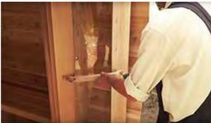
Répétez ce processus pour la poignée intérieure en l'installant à la hauteur souhaitée, centrée horizontalement sur la porte.
