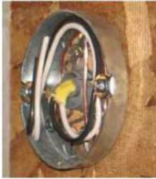
Nous recommandons l'utilisation d'un boîtier électrique rond à profil bas plutôt qu'un boîtier octogonal standard. Il peut être monté en surface, à l'intérieur du sauna, avec un appareil d'éclairage placé au-dessus du boîtier.
