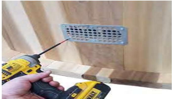
Installez 1 des grilles d'aération en acier inoxydable sur les trous d'entrée à l'extérieur du sauna en les centrant à l'aide de vis de 1 ½". (6pcs)
