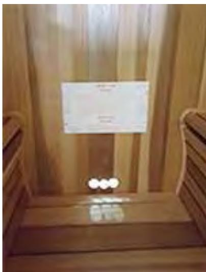
À l'aide du gabarit fourni, percez quatre trous de 9/64" pour fixer l'appareil de chauffage au mur.
