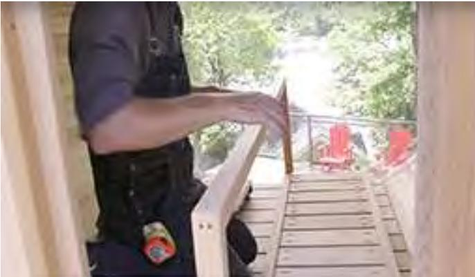
À l'aide des trous pré-perçés, assemblez le support du banc de salon à la paroi inférieure du banc avant plus longue à l'aide de vis de 2" (51 mm).
