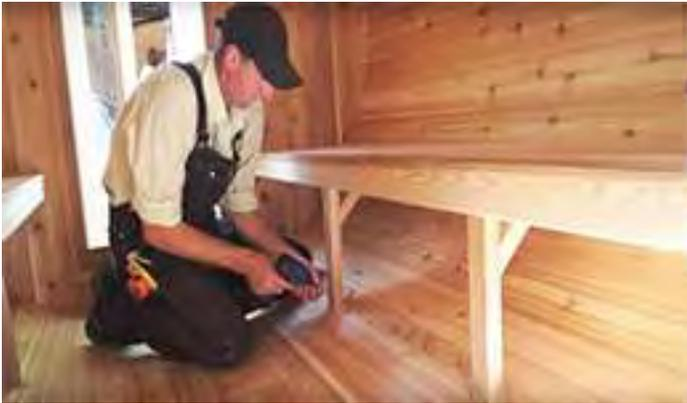
Fixez le pied de support au sol à l'aide d'une vis de 2 ½" (64 mm) dans chaque support.
