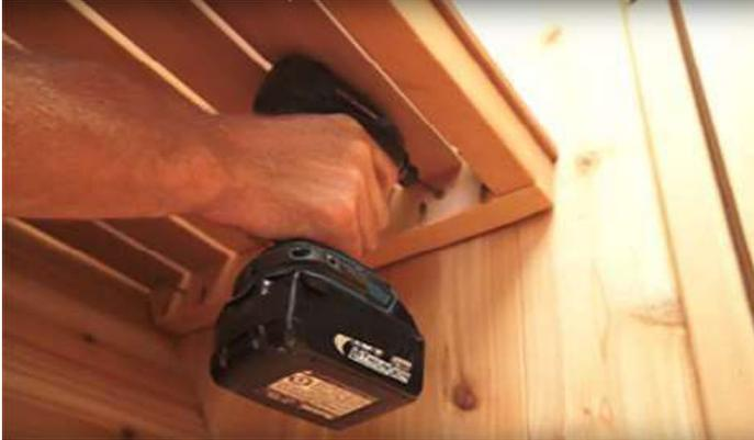
Fixez le siège de porche à la paroi avant par le dessous à l'aide de (3) - 2 ½" (64 mm) vis.
