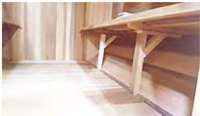
Placez les 4 supports de siège sous les bancs en les alignant avec le support de siège incurvé au bas du banc.
