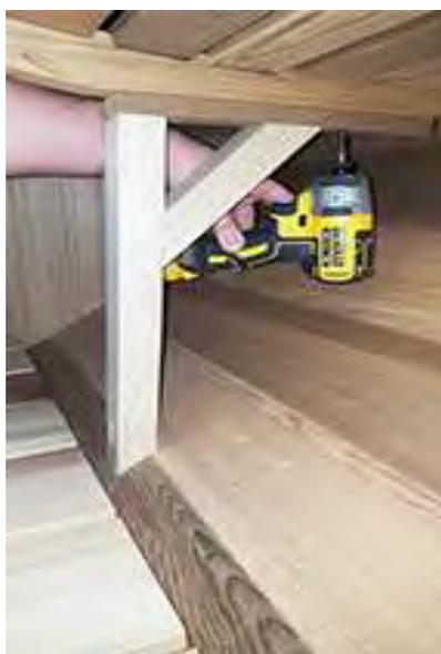
En vissant du bas vers le haut dans le support du siège, utilisez 3 vis de 2 ½" (64 mm) pour fixer le support du siège au banc.
