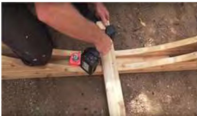
Fixez la douelle dans le support à l'aide de vis de 2 ½" (64 mm).
