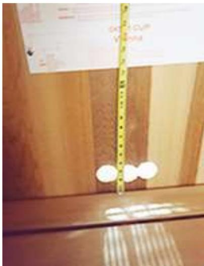
Mesurez les distances appropriées pour le gabarit de l'appareil de chauffage selon les instructions du fabricant de l'appareil.
