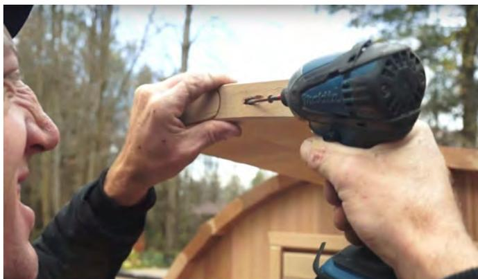
Fixez chaque pièce à travers les trous pré-percés à l'avant de chaque pièce avec une vis de 2 1/2".
