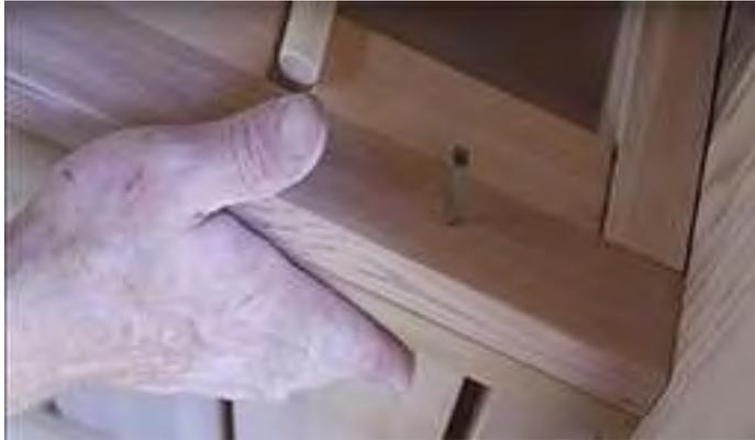
S'assurer que le banc est à niveau avec le support du banc et le fixer avec des vis de 2 ½" (64 mm) dans les trous pré-perçés.
