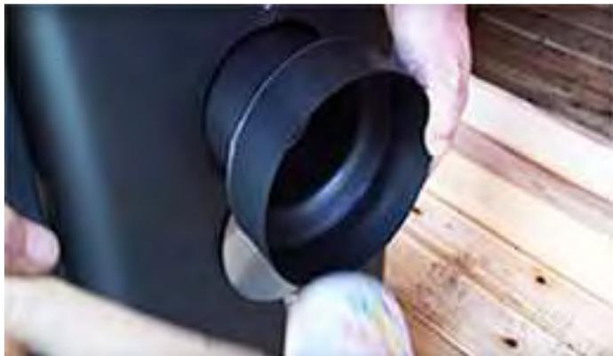
Insérez l'adaptateur de cheminée dans le trou arrière en tapant avec un maillet en caoutchouc jusqu'à ce qu'il soit bien ajusté.
