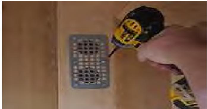
Installez l'autre couvercle d'évent en acier inoxydable sur les trous de sortie à l'extérieur à l'aide de vis en acier inoxydable de 1-1/2". (6pcs)
