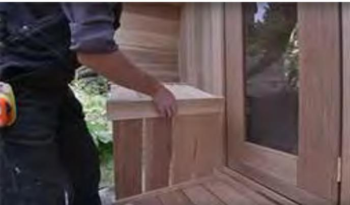
Assemblez les 2 pièces du siège de la véranda à l'aide de vis de 2 ½" (64 mm).
