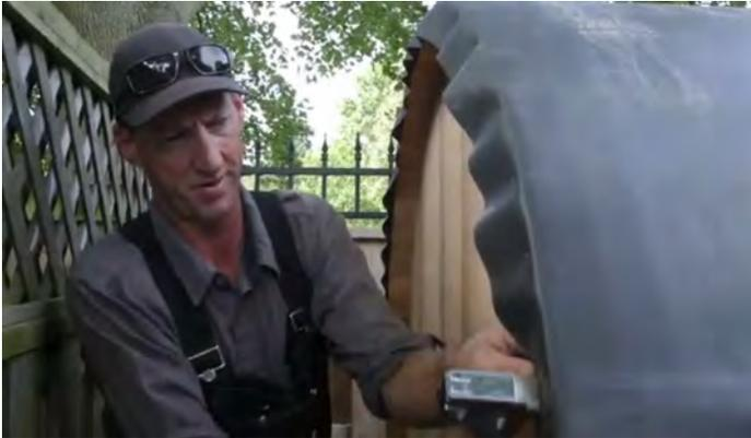
En commençant par une extrémité du sauna, tirez sur la membrane et fixez-la au bord des douelles avec des agrafes.
