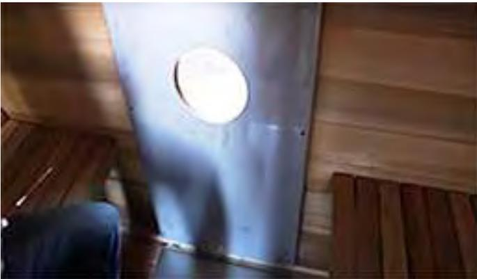
Installez le bouclier mural arrière centré sur le trou de cheminée avec des vis de 1 ½" (38 mm).
