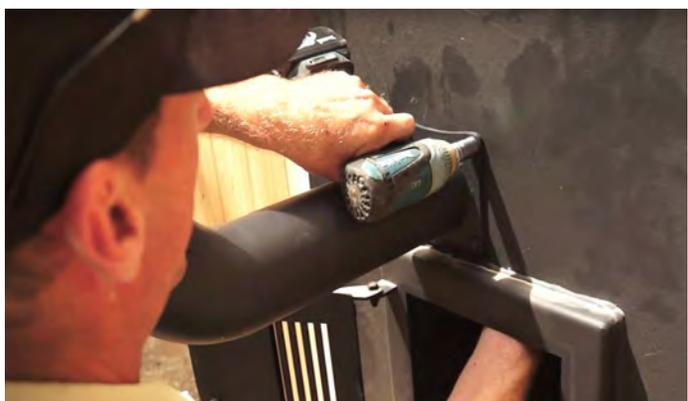
En utilisant une clé pour maintenir l'écrou à l'intérieur, serrez complètement les boulons avec une perceuse à percussion ou une clé à molette.
