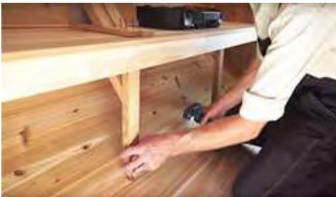
Espacez les supports de banc sous les traverses au bas des bancs.
