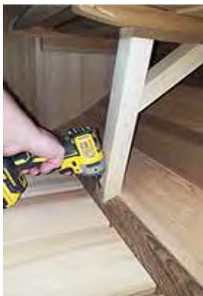
À l'aide d'une vis de 1 2 ½" (64 mm), fixez le bas du support du siège à la douelle inférieure du sauna tonneau.
