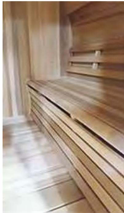
Pour installer le dossier signature, positionnez-le sur le mur à la hauteur désirée et fixez-le avec des vis de 2 ½" (64 mm).
