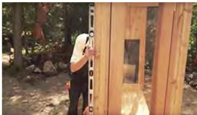
En utilisant votre niveau de charpentier et un maillet en caoutchouc, mettez à niveau les murs avant et arrière.
