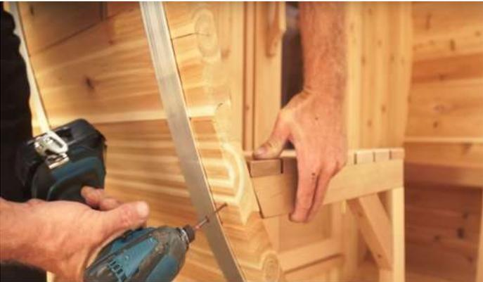
Vissez l'avant du banc de véranda dans le mur depuis l'extérieur à l'aide d'une vis de 2 ½" (64 mm).
