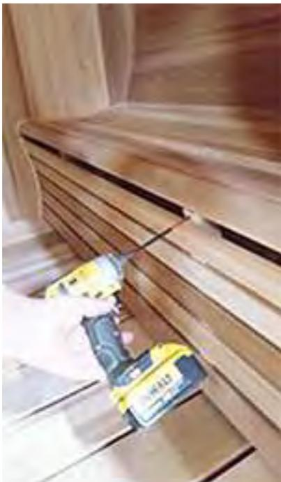
Vissez l'enceinte avant et les bancs ensemble sur les languettes avant avec des vis de 2 ½" (64 mm).
