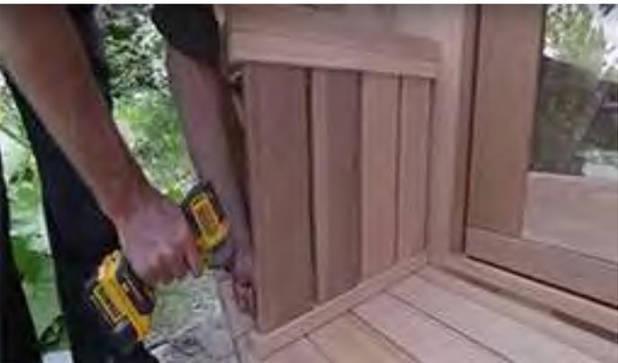
Fixez le banc au sol et à la paroi du sauna à l'aide de 3 vis de 2 ½" (64 mm) en haut et en bas.
