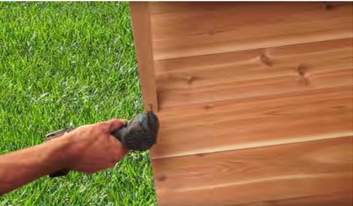
Fixez le pied au sol à l'aide d'une vis de 2 ½" (64 mm).
