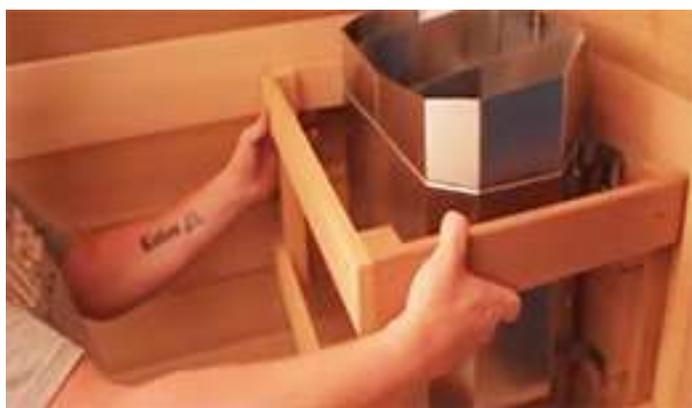
Placez la protection de l'appareil de chauffage assemblée autour de l'appareil de chauffage électrique et vissez au mur à l'aide de (4) vis de 2 1/2" (64 mm).
