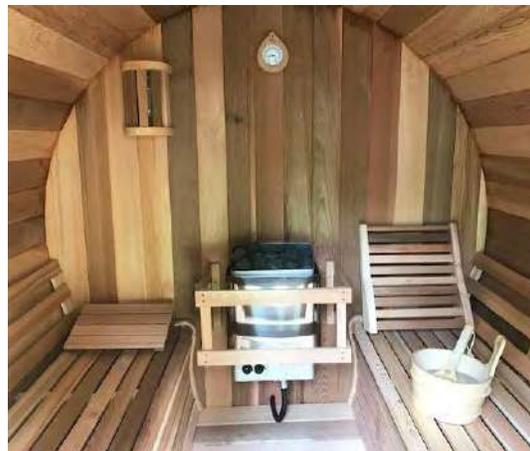
**\*Le câblage du poêle électrique entre la plupart du temps dans le sauna sous le poêle, comme le montrent les deux photos ci-dessus.**
