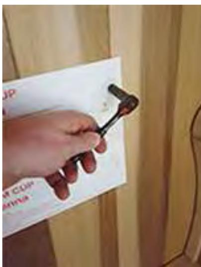
Serrez ces vis jusqu'à ce que leurs têtes soient à environ 6 mm du mur.
