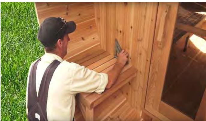
Utilisez un niveau ou une équerre de charpentier pour vous assurer que le siège de la véranda est de niveau.
