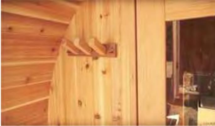
Installez le porte-serviettes à la hauteur désirée sur le mur extérieur à l'aide de vis de 1 ½" (38 mm).
