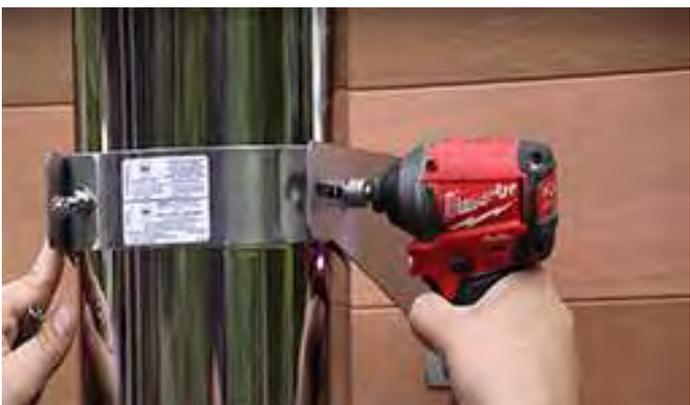
Serrez les supports de cheminée à l'aide d'une douille ou d'une clé de 7/16" (11 mm) jusqu'à ce qu'ils soient bien serrés.
