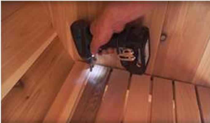
Fixez les bancs aux supports muraux en les attachant avec des vis de 1 ½" (38 mm).
