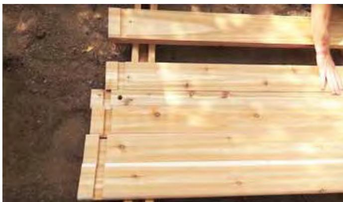
Commencez à poser les douelles murales. Faites en sorte que les rainures de la douelle soient alignées avec la douelle inférieure correctement positionnée.
