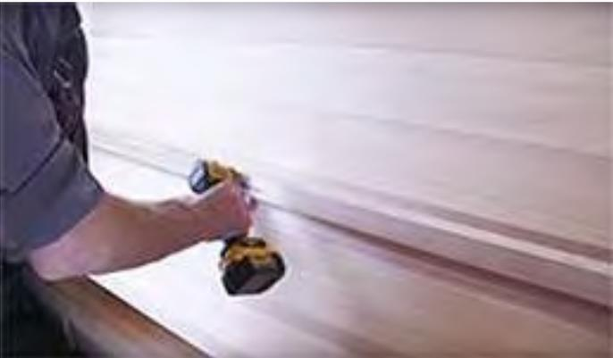
Positionnez l'ensemble en place et fixez-le aux murs et au plancher du sauna à l'aide de 5 vis de 2 1/2" (64 mm) sur les rails supérieurs et inférieurs.
